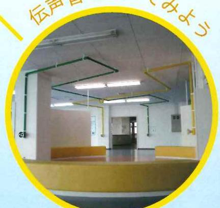
船上での通信具として用いられる伝声管を天井に設置。
